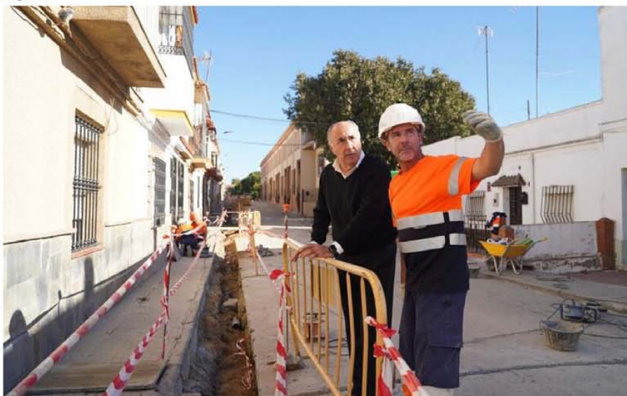
Visita a las obras
