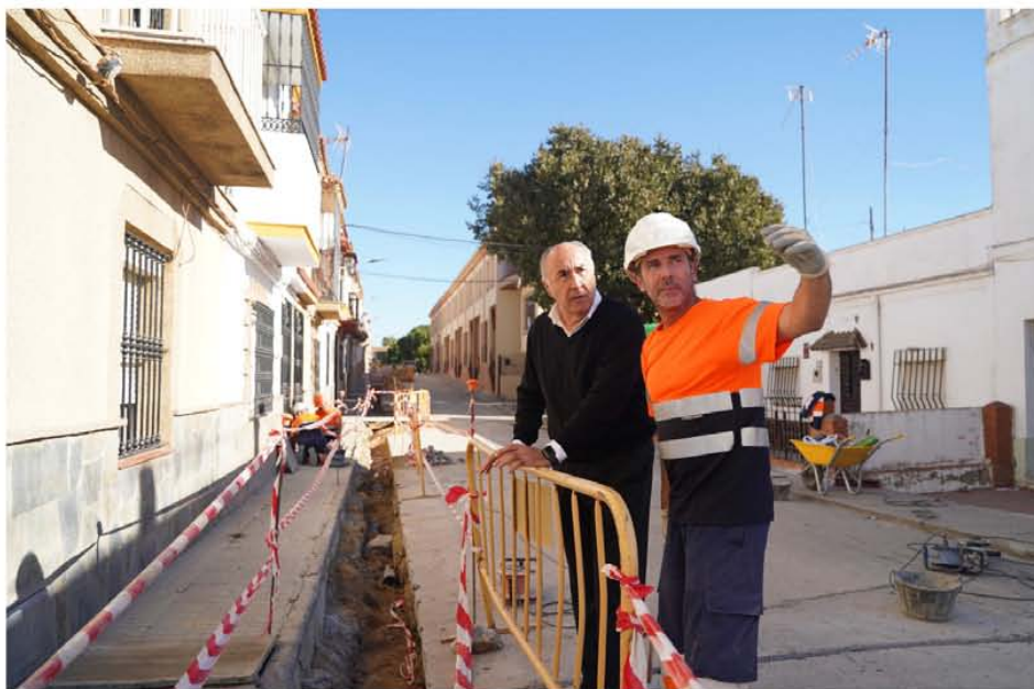
FOTO OBRA PESCADORES
