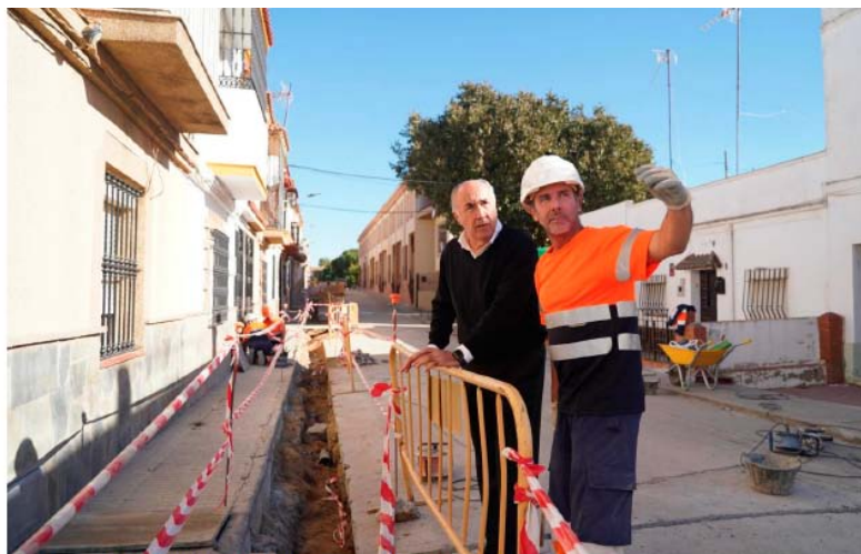
Obras en la barriada de Pescadores, en Algeciras. - AI
